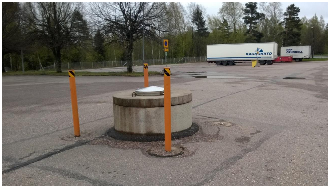
Kuva 1 Valion vedenottamon kaivo sijaitsee tehtaan piha-alueella.
