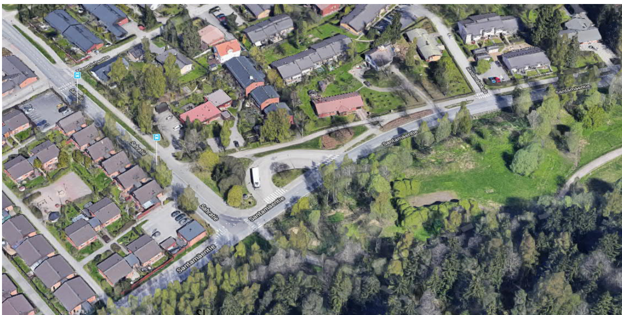
Ilmakuva etelästä. / Flyfoto från söder.
